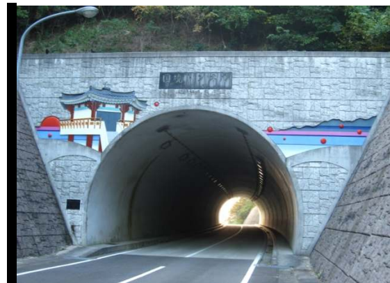
比田勝側から見た国境トンネル
