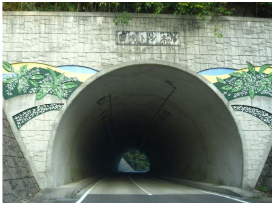
鰐浦側から見た国境トンネル
