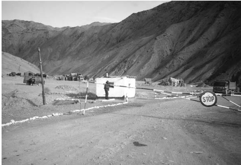
中国人労働者による峠の拡張工事
