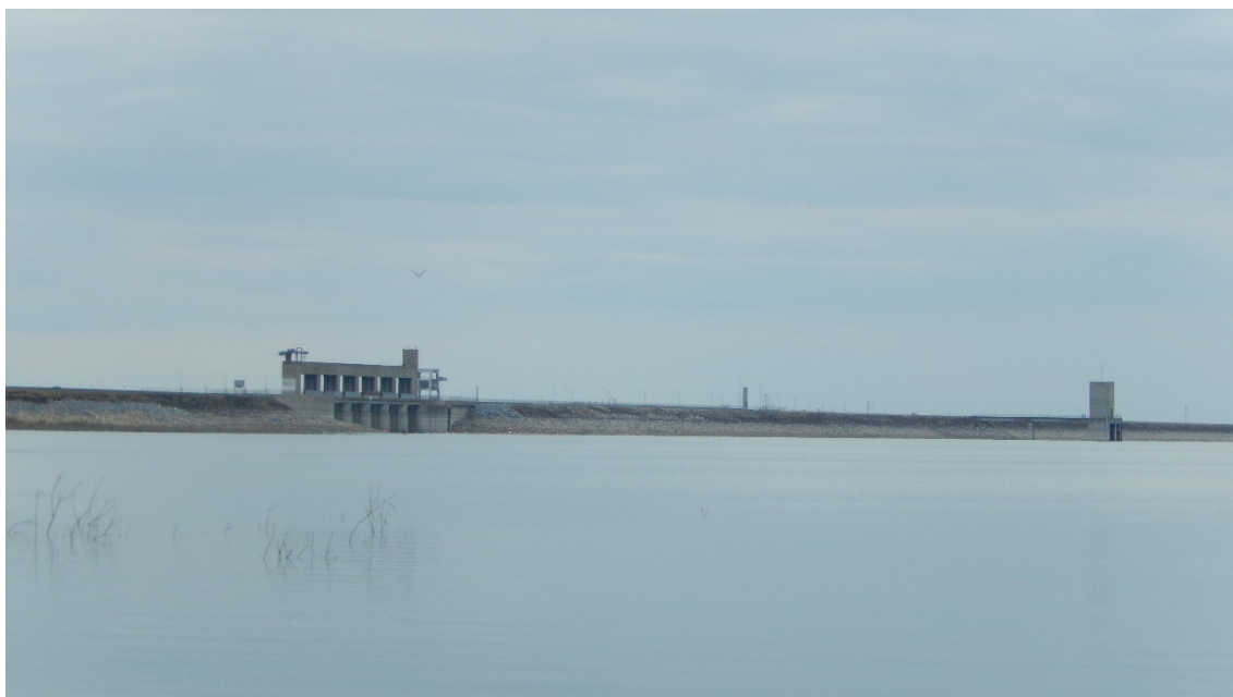
【ファルコンダム】
